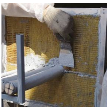
► Процесс монтажа конструкции ОГРАКС-КП
